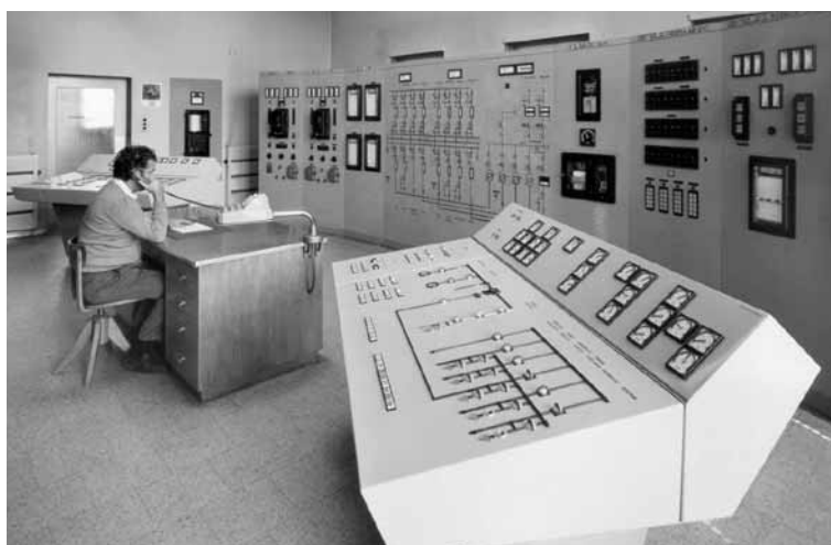
Il Centro di Comando Ponte Ascona nel 1970
